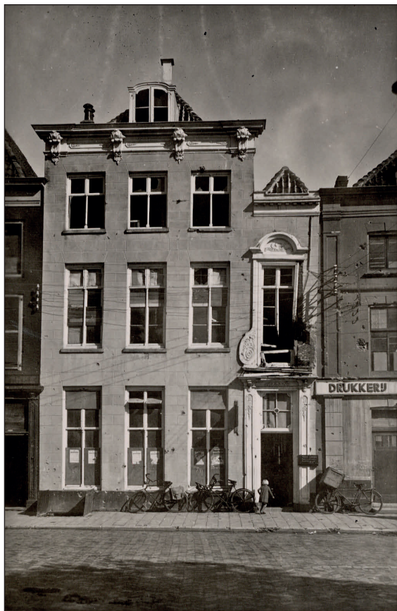
Het door oorlogsgeweld beschadigde gebouw van de openbare leeszaal aan het Bellamypark, 1945. (Fotocollectie Gemeentearchief Vissingen)
