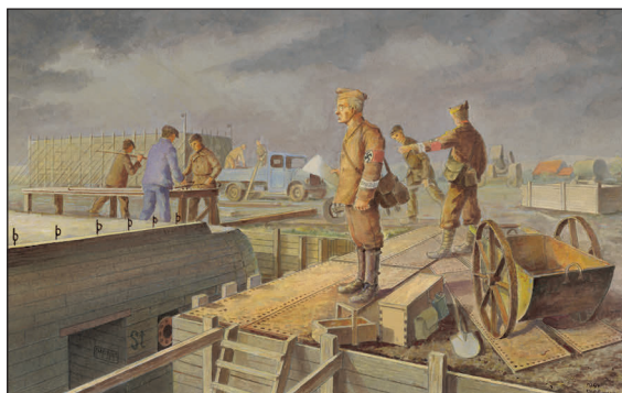
De bouw van bunkers op Walcheren door Organisation Todt; gemengde techniek C. van der Burght. (Historisch Topografische Atlas Gemeentearchief Vlissingen)
